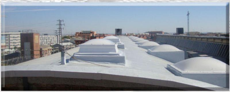
Chimeneas y exutorios son elementos básicos para la extracción de gases producidos en el interior del edificio industrial y son puntos singulares a tratar y a mantener para lograr una impermeabilización duradera.
